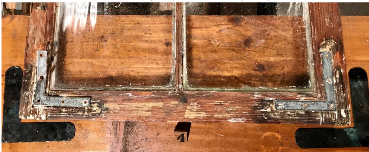
Eckwinkelreparaturen
