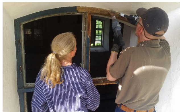
Farbentfernung am Blockrahmen
