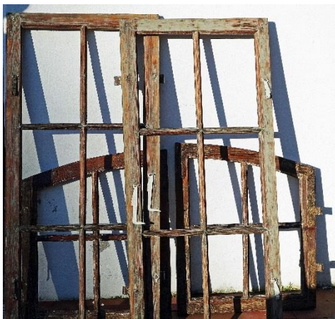
8) Musterflügelensemble nach Farbentfernung
