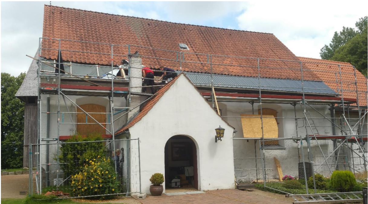
Fensterbaustelle St. Johannes
