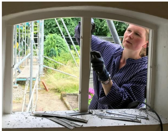
Beschichtungsentfernung am Rahmen
