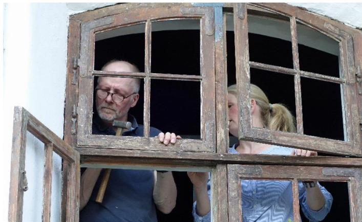
9) Musterflügel beim Probehängen
