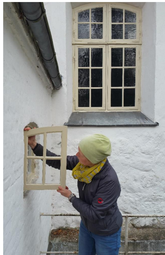
Einbau der Flügel
