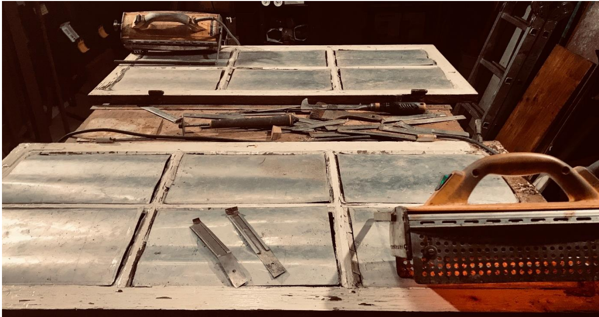
Farbentfernung mit Infrarotgeräten
