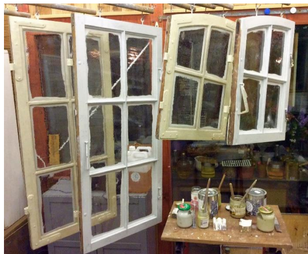
Flügel trocknen in der Werkstatt
