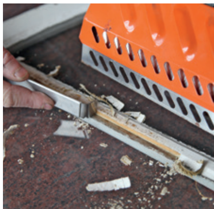
Kittlampe zur Kittentfernung. In begrenztem Umfang lässt sie sich auch zur Farbentfernung verwenden
