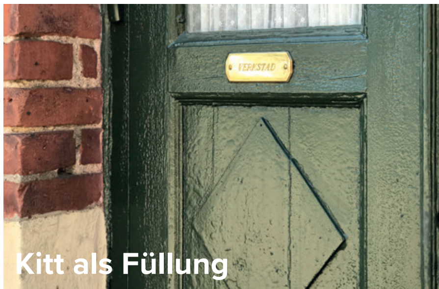
Tür von 1926. Hundert Jahre einfacher „Alterungsverzögerungs“-Maßnahmen Leinölkitt in Rissen. Direktes Überstreichen der gealterten Oberfläche mit neuer Leinölfarbe.
