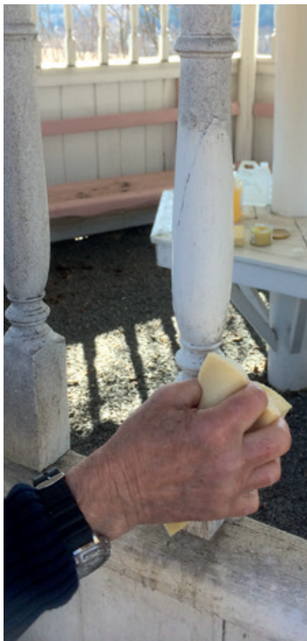
Gestrichene und ungestrichene Flächen vor Farbauftrag gründlich reinigen
