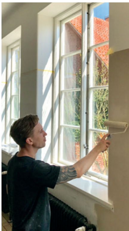
Spachteln und Streichen mit Linus. Verwenden Sie Pinsel, Rollen oder verschiedene Spachtel nach Bedarf. Streichen Sie mit satt getränkter Rolle!
