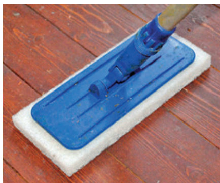
Leinölwachs lässt sich am leichtesten mit einem rauen Scheuerschwamm (z.B. Scotch Brite) auftragen
