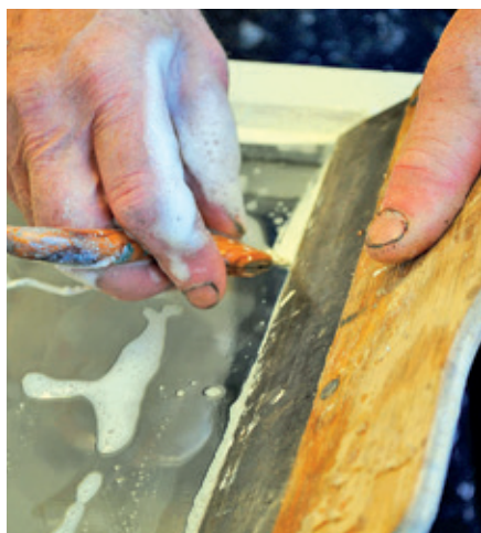
Schneiden Sie die Kanten der Kittfalze unter schwacher Seifenlauge
